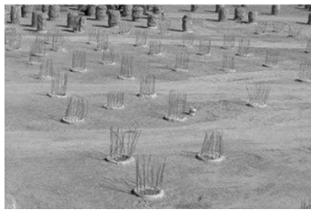
图5 桩头破除效果
